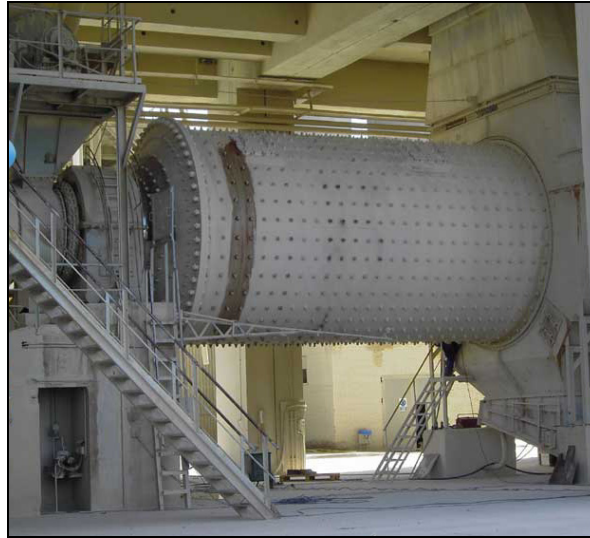
Figure 3.2.76. Broyeur à ciment. Cimenterie de Holcim Espagne.
