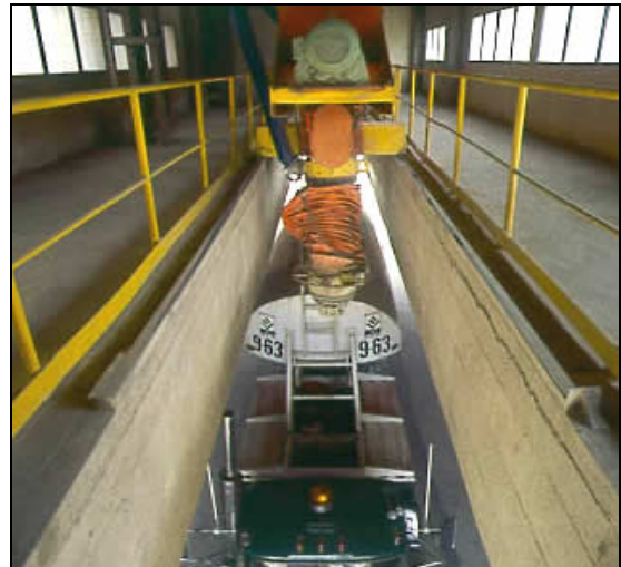
Figure 3.2.80. Système de chargement de ciment en vrac.
